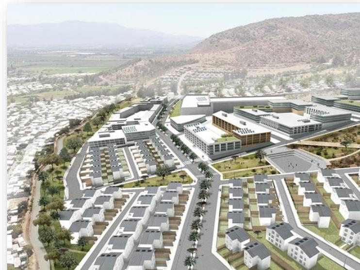
La Etapa I contempla las siguientes tipologías de vivienda: Viviendas **tipo “A”** de **61,36 m<sup>2</sup>**; viviendas **tipo “B”** de **74,38 m<sup>2</sup>**. Las Viviendas contemplan de estructura de **hormigón armado H.A., envolvente térmica EIFS y Ventanas Termopanel** en dormitorios.
